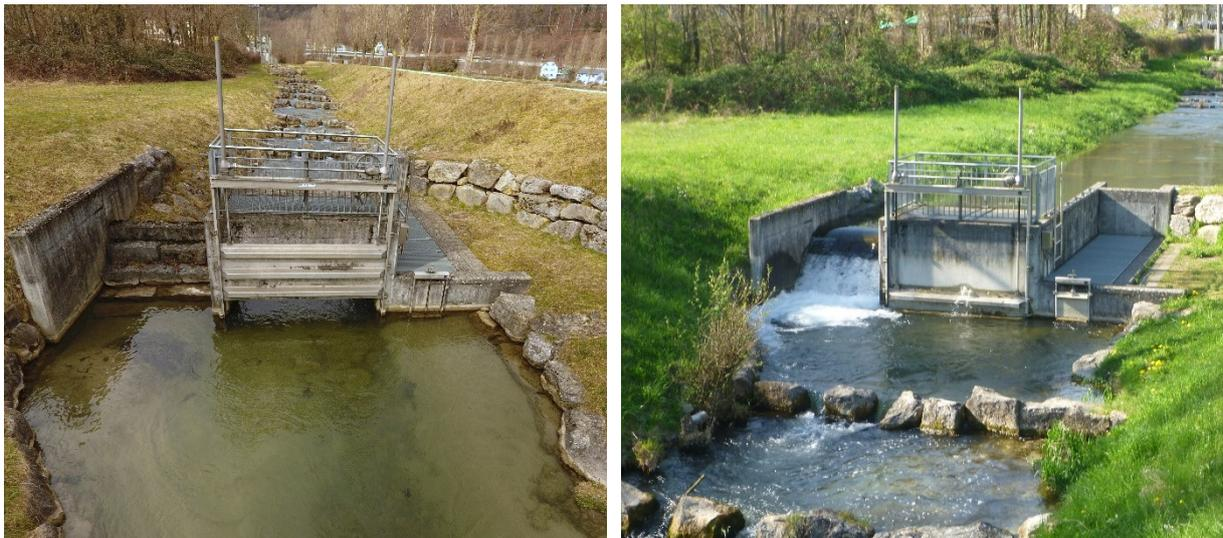
**Abbildung 5:** Zählbecken Winznau mit geöffnetem (links) und geschlossenem (rechts) Schütz. Bei geschlossenem Schütz strömt das Wasser über den Überfall links im Bild und durch das Zählbecken auf der rechten Seite.
